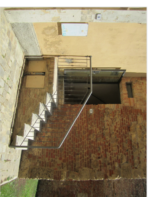
FOTO 10 [Tav. 2 di 3] - Ingresso Sala Riunioni Piano Primo (dx accesso Chiostro)
